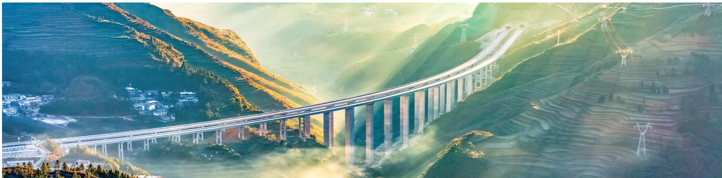
贵州省分行支持建设的盘兴高速背武甲特大桥
