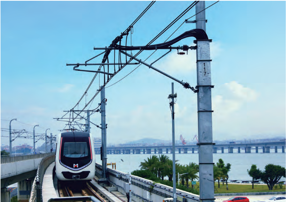
厦门分行为厦门轨道交通 1 号线提供资金支持
