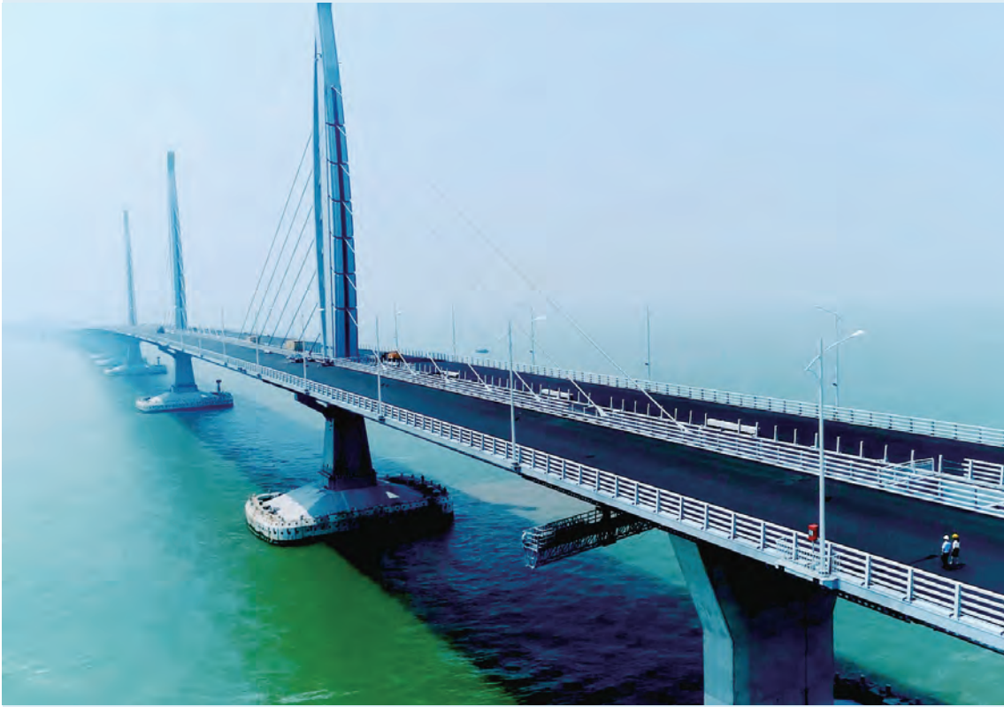
港珠澳大桥是世界总体跨度最长、钢结构桥体最长、海底沉管隧道最长的跨海大桥
